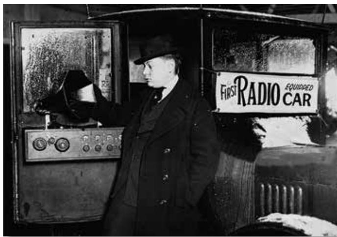
En 1922 se adaptó un radiorreceptor doméstico a un Ford Model T de la época. El aparato podía ser manipulado con tan sólo dos botones giratorios. Esta radio fue considerada la primera radio instalada en un vehículo.
